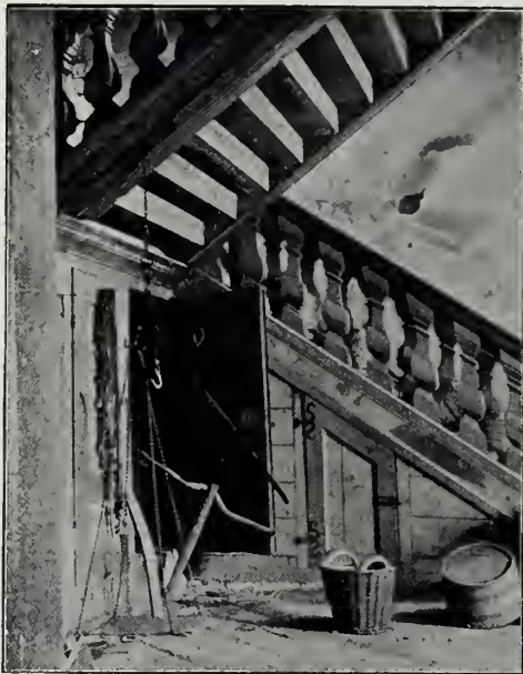
Fig. 242. Burg Langenau. Treppenhaus im Marioth'schen Bau.
