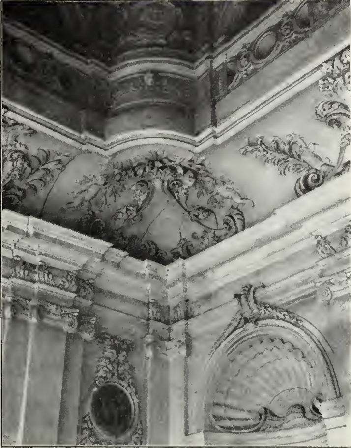
Fig. 15. Weilburg. Mittelsaal der Orangerie.
